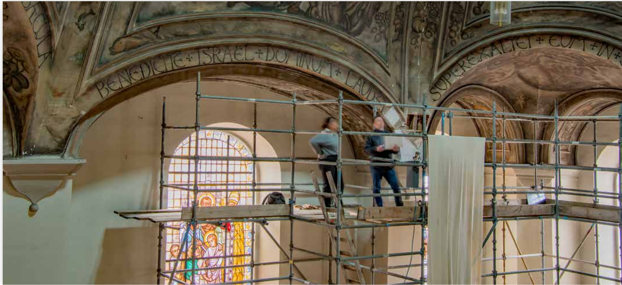
Zicht op steiger, met links onder het teruggeplaatste glas-in-loodvenster.
